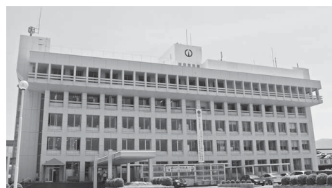
敦賀市役所庁舎
